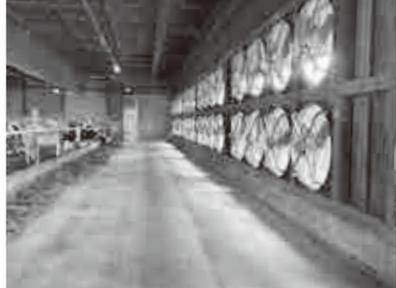
▲ ロボット牛舎内の様子 トンネル換気を導入し環境面に気を付けている
